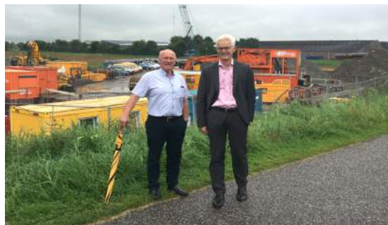
SGP-waterschapbestuurders: J. van Helden en W. de Jong bij de bouw van sifon onder Havenkanaal Middelharnis
