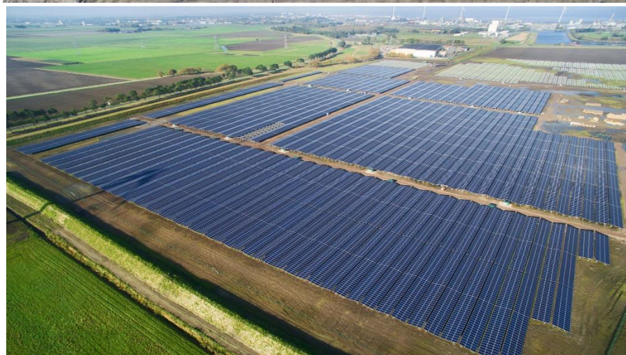
Bijlage 2: Voorbeeld van opslag warm water en een veld met zonnepanelen
